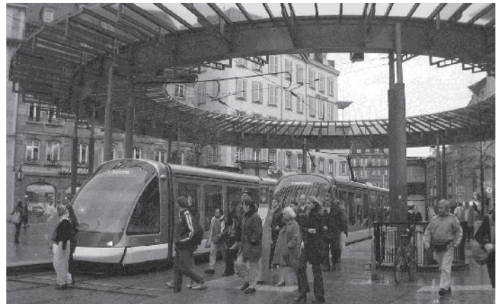
フランス・ストラスブール市のLRT
